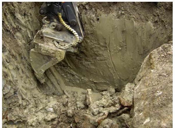
Kuva 15. Rengaskaivoa rakennetaan saviseen maaperään. Savialueilla kaivon pohjan (kuva 38) tai sen läpi työnnetyn siiviläputken (kuva 74) on ulotettava savien alla oleviin vettä johtaviin hiekka-, sora- tai hiekkamoreenikerrostumiin asti, jotta pohjaveden saanti on mahdollista. (Kuva: Toivo Lapinlampi)
