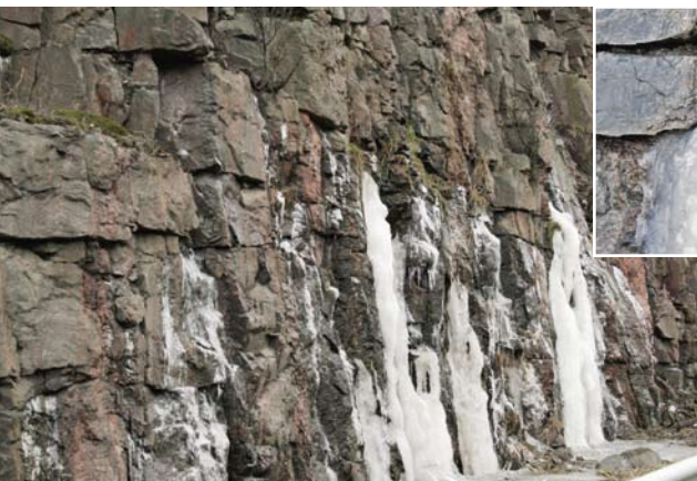
Kuva 25.1. Korkeasta kallioleikkauksesta näkyy parhaiten vaaka- ja pystyrakojen suhde. Kallion rakoihin maanpinnalta virrannut sadevesi kulkeutuu kalliopeirässä alaspäin maan vetovoiman vaikutuksesta kohti alempana olevaa pohjaveden pintaa.
